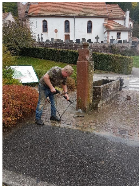
Nettoyage de la fontaine sur la place centrale et réfection des joints du pavage
