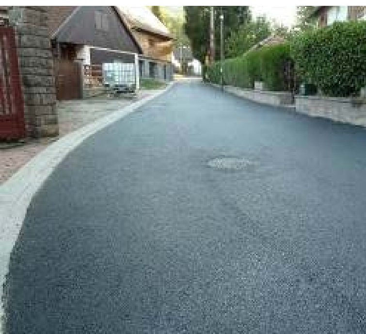
Finition de la rue des Champs d'Yvrée par la pose d'enrobé
