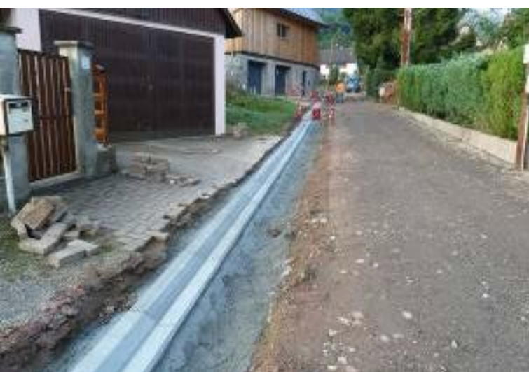
Pose des bordures béton pour stabiliser les accotements
