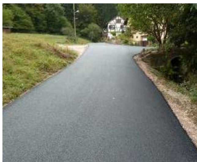
Réfection de la partie supérieure de la rue du Schnarupt
