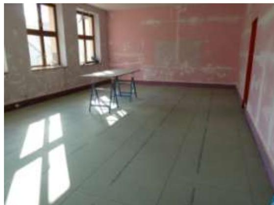
Après avoir rebouché l'ensemble des fissures, la pose d'un revêtement en fibre de verre sur les murs a été effectuée afin de garantir une surface uniforme. Ces travaux de préparation terminés, la première couche de peinture a pu être appliquée sur le plafond et les murs.
