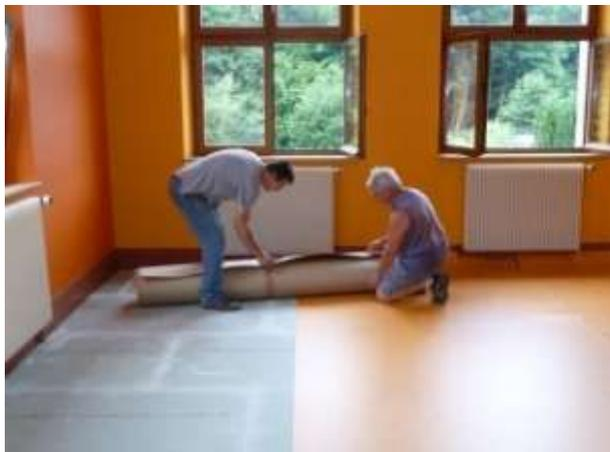
Seule la réalisation des joints entre les différents lés a nécessité le recours à une entreprise spécialisée avec un outillage et un savoir faire particuliers.
