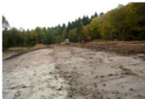
Décharge en cours de réhabilitation
