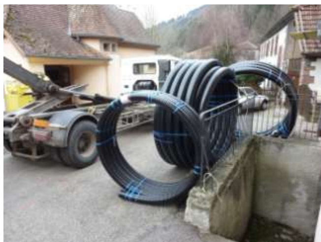
Livraison et pose du réseau de chaleur
