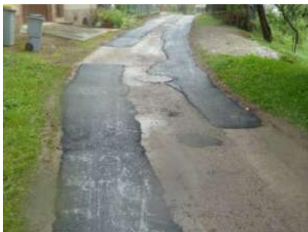
**UNE DOUZAINNE DE TONNES D'ENROBES ET DEUX COUCHES DE BITUME ET GRAVIER ONT ETE NECESSAIRES POUR REDONNER UNE SURFACE PLANE A LA CHAUSSEE.**
