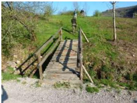
La passerelle, enjambant le ruisseau du Schnarupt, sur le Sentier du Patrimoine, ne permettait plus un passage sécurisé. Au fil des années, les rondins d'épicéa commençaient à se dégrader fortement.
