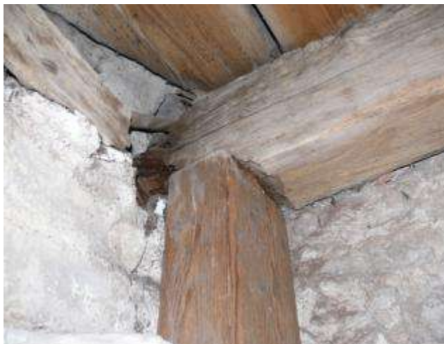
Renfort sous poutre porteuse
