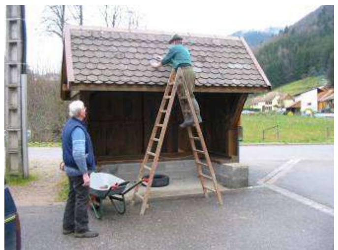
Le remplacement des tuiles cassées et la fixation des planches enlevées redonnent un aspect agréable à l'abri bus.
